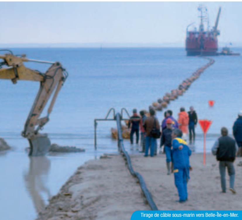
Tirage de câble sous-marin vers Belle-Île-en-Mer.
