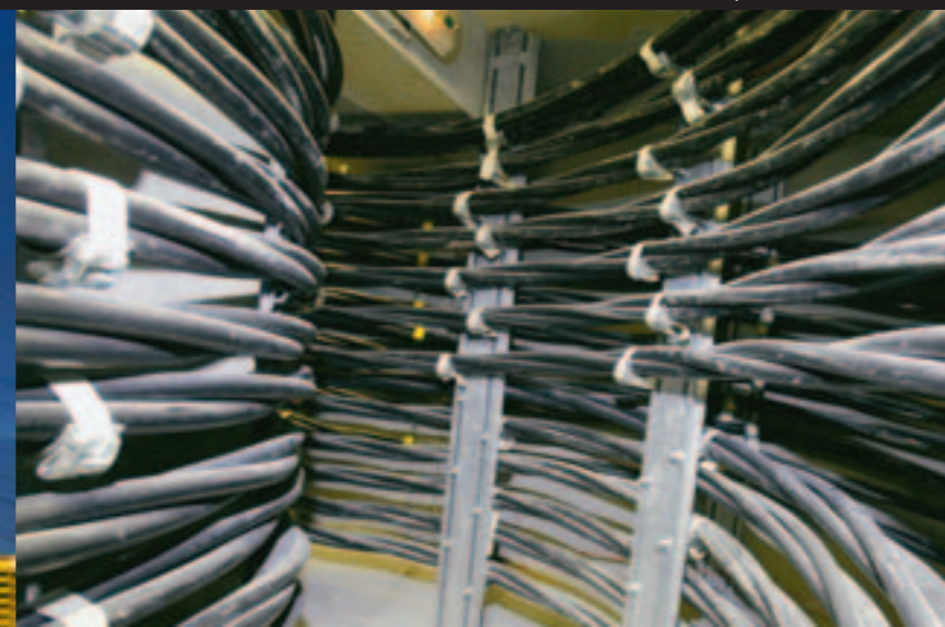
Câbles très haute tension acheminant le courant vers les transformateurs de quartier.
